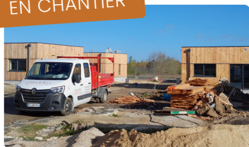
Châtillon-sur-Cher (41) 12 logements Opération en VEFA
